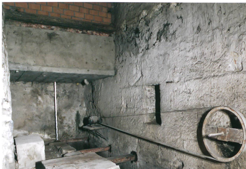
Fig. 4: Plateau de Diesse, Lamboing, Les Moulins 1. Mur en gros appareil qui à l'origine formait la façade est; le coursier maçonné témoigne de la dimension de la roue en bois aujourd'hui disparue. Vue vers le sud.
