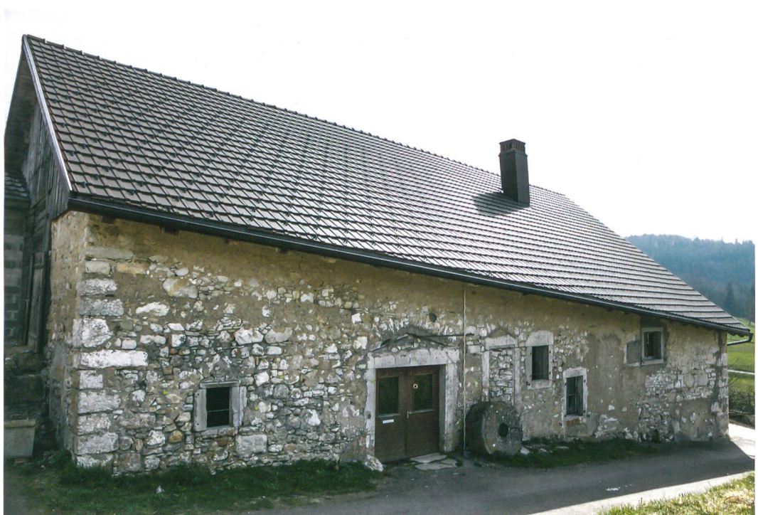
Fig. 6: Plateau de Diesse, Lamboing, Les Moulins 1. Façade ouest avant travaux. Diverses baies, parfois obturées, témoignent des modifications apportées au bâtiment au cours des générations.
