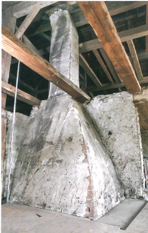
Fig. 5: Plateau de Diesse, Lamboing, Les Moulins 1. Au-dessus du foyer de la cuisine, un magnifique tué en briques revêtu d'un enduit à la chaux est encore conservé. Vue en direction du nord-est.
