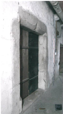
Abb. 4: Ligerz, Chlyne Twann 7. Erdgeschoss. Der westseitige Kellerzugang. Das Türgewände besteht aus Jurakalkstein, der Türsturz ist mit einem Eselsrücken hervorgehoben. Die seitlich heruntergezogene Fase endet jeweils in einem schrägen Abwurf. Blick nach Osten.
