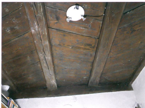
Abb. 5: Ligerz, Chlyne Twann 7. Zweites Obergeschoss. Die Decke im östlichen Saal wurde mit fischgrätfförmig eingeschobenen Bohlen gebaut; die einzelnen Hölzer verfügen über eine Strichzier. Blick nach Nordwesten.
