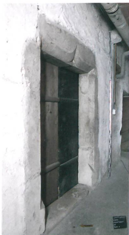
Abb. 4: Ligerz, Chlyne Twann 7. Erdgeschoss. Der westseitige Kellerzugang. Das Türgewände besteht aus Jurakalkstein, der Türsturz ist mit einem Eselsrücken hervorgehoben. Die seitlich heruntergezogene Fasse endet jeweils in einem schrägen Abwurf. Blick nach Osten.
