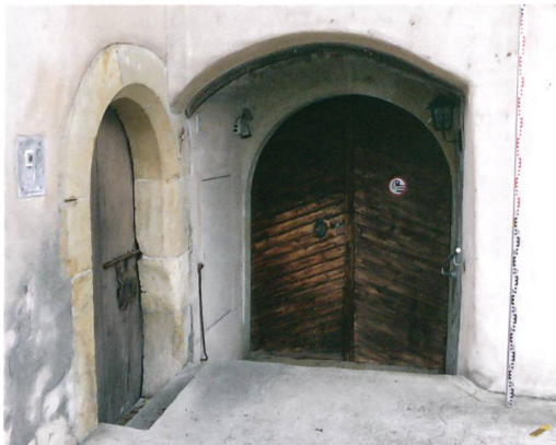
Abb. 6: Ligerz, Chlyne Twann 7. Erdgeschoss. Direkt neben dem südseitigen Haupteingang in den grossen Kellerraum wurde fassadenparallel ein kleinerer Gewölbekeller angefügt. Das Gewände ist im unteren Bereich ausgebuchtet, damit die grossen Weinfässer durchgeschoben werden konnten. Blick nach Nordwesten.
