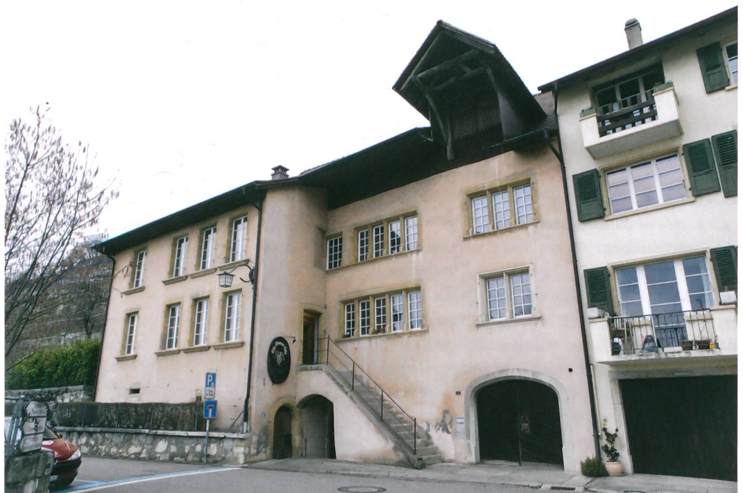
Abb. 1: Ligerz, Chlyne Twann 7. Südfassade. Das Haus wurde im Laufe der Zeit stetig erweitert. Deutlich stechen die nach Süden vorspringende Erweiterung und der nachträglich angebaute Hochengang ins Auge. Die jüngste Erweiterung nach Westen zeichnet sich durch die abgesetzten Fenster am linken Rand ab. Blick nach Nordwesten.
