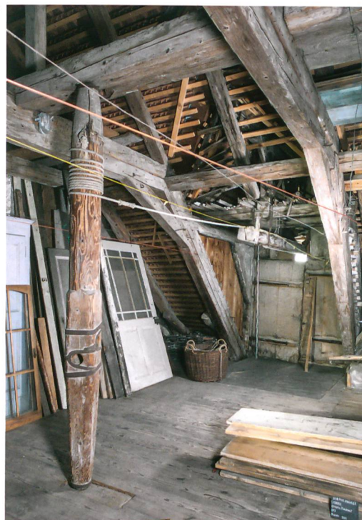
Abb. 3: Ligerz, Chlyne Twann 7. Dachgeschoss. Der Aufzugsgiebel wurde zusammen mit dem Dachstuhl gebaut. Links im Bild ist die originale Winde zu sehen, mit deren Hilfe die Lasten unter das Dach befördert werden. Blick nach Südosten.
