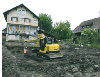
56 Kirchlindach, Lindachstrasse 12b
