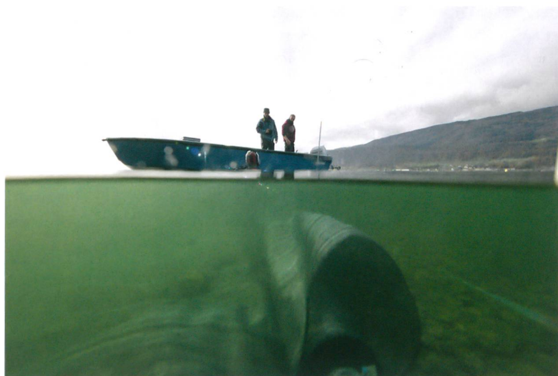
Fig. 9 : Sutz-Lattrigen, Rütte. Pose de la natte géotextile devant protéger la frange d'érosion.
