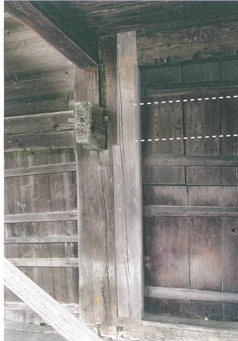
Abb. 16: Schwarzenburg, Junkerngasse 17. Sowohl der Stalleingang (links) als auch die alte Haustür (rechts) reichten ursprünglich nur bis zur Höhe der Bundbalken. Bei der Erhöhung des Hausganges um 1870 wurde der Balken (gestrichelt) entfernt. Der Türpfosten (hell markiert) des jetzigen Hauseinganges wurde in die alte Passstelle eingefügt. Blick nach Nordwesten.
