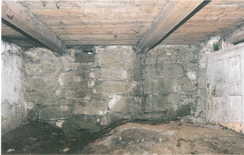
Abb. 20: Schwarzenburg, Junkerngasse 17. Die beiden «Träme» des südöstlichen Kellers trugen den Stubenfußboden und fingen die Auflast des Ofens durch einen nicht erhaltenen Ständer ab. Die einzige nicht verputzte Wand besteht aus wiederverwendetem Altmaterial. Könnten hier die Reste des alten Webkellers verbaut worden sein? Blick nach Nordosten.
