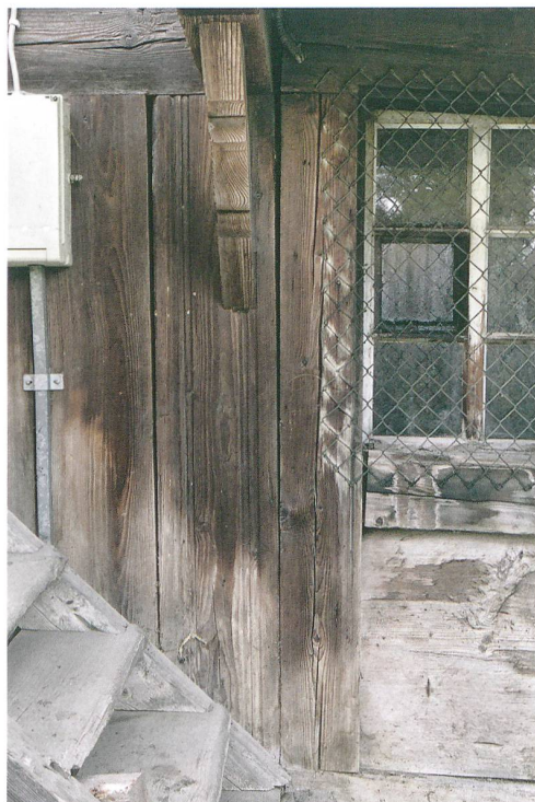
Abb. 24: Schwarzenburg, Junkerngasse 17. Übergang zwischen Küche und südöstlicher Stube. An den profilierten Eckständer der älteren Stube (links, mit Bundvorstoss und Bug) stösst der schmucklose Eckständer der jüngeren Küche (rechts). Blick nach Südwesten.
