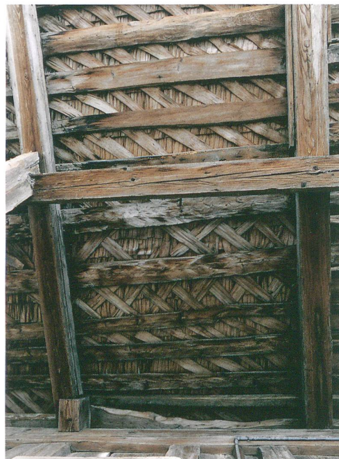
Abb. 12: Schwarzenburg, Junkerngasse 17. Blick in den Vordachbereich am Querbund 3 mit Flugpfette und Vordachbug (links). Auf der mehrfach umgesetzten Dachlattung haben sich grössere Flächen der alten Nagelschildeleindeckung erhalten.
