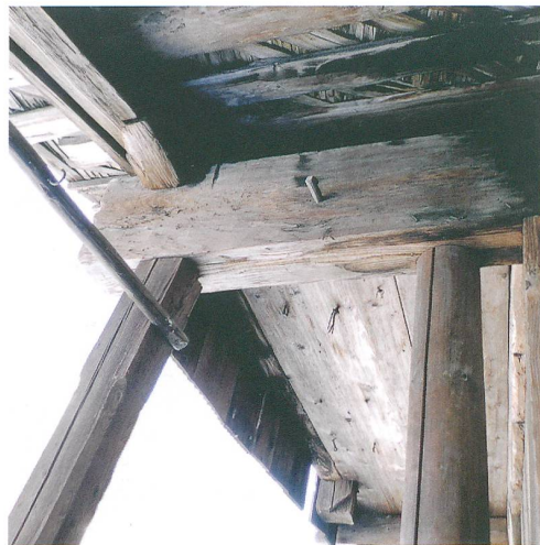
Abb. 14: Schwarzenburg, Junkerngasse 17. Blick von der Giebellaube auf den Querbund 1. Am Stirnholz der Mittelpfette ist der aufgekämmte Kehlbalken sichtbar. Darüber zeigt der aufliegende Rofen eine Nutung für den ehemaligen Wetterschild. Blick nach Südosten.
