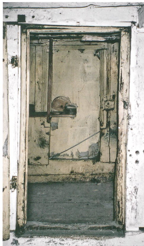
Abb. 5: Erlenbach, Ringoldingen, Heidenhaus. Westlicher Hausteil, Obergeschoss. Blick aus Gaden 1 an die Gadenür zu Gaden 2. Das Türge- wände ist mit einem von Hohlkehlen gesäumten Falz verziert. Solche vergleichsweise reichen Dekorelemente wurden mittels Profilhobel an den Bauteilen angebracht. Blick nach Osten.
