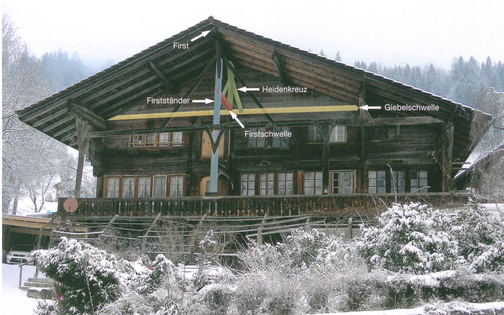
Abb. 18: Erlenbach, Ringoldingen, Heidenhaus. Südfassade mit Heidenkreuz und Ständersystem. Blick nach Norden.
