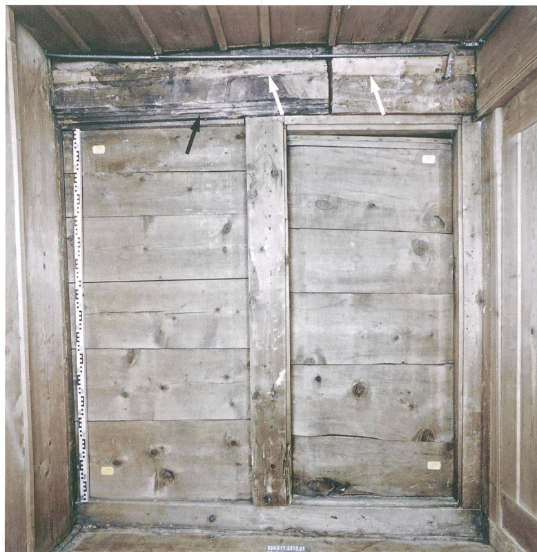
Abb. 33: Erlenbach, Ringoldingen, Heidenhaus. Zimmer 3. Die weissen Pfeile markieren die zurückgestrafte Konsole am Deckenrähm. Der schwarze Pfeil markiert die Profilierung, welche am Längsstoss fehlt. Blick nach Norden.
