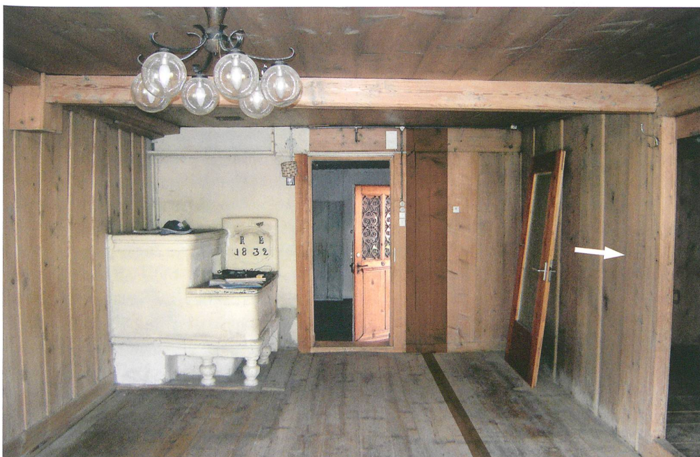
Abb. 27: Erlenbach, Ringoldingen, Heidenhaus. Zimmer 2. Die Ostwand der Bauphase III (weisser Pfeil) vergrößerte die Stube um einen Meter. In brauner Farbe ist auf dem Bild der Standort der Ostwand aus Bauphase I und II gekennzeichnet. Die Ofenplatte bezieht sich auf Rudolf Bächler, Besitzer des östlichen Hausteils von 1816 bis 1864. Blick nach Norden.
