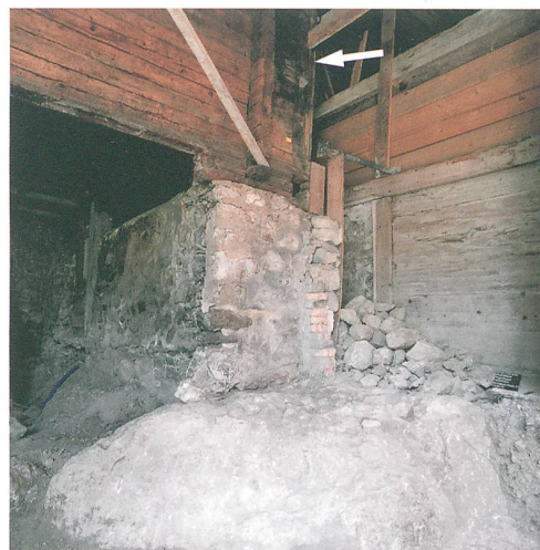
Abb. 31: Erlbach, Ringoldingen, Heidenhaus. Links: Fortsatz der Ostmauer nach Norden. Auf der Mauer liegen die Schwelle und der Vorstoss der Ostwand. Blick nach Südosten. Rechts: Blick auf die Nord- und Ostmauer während der Umbauarbeiten im Sommer. Die Mauer steht auf dem Felsen. Nach Süden bildet sie eine Stirn oder einen Absatz, dahinter zeigt sich die Vormauerung. Blick nach Nordwesten.
