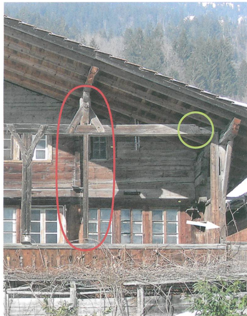
Abb. 28: Erlenbach, Ringoldingen, Heidenhaus. Südfassade. Roter Kreis: Der Ständer wurde nachträglich unter die untere Mittelpfette gestellt. Grüner Kreis: Beim Einsetzen des zusätzlichen Eckständers musste die Kopfstrebe abgesägt werden. Blick nach Norden.
