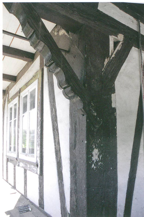
Abb. 5: Urtenen, Solothurnstrasse 53, Obergeschoss, südöstlicher Eckständer mit aufgeblatteten Kopfstreben von Phase 3.
