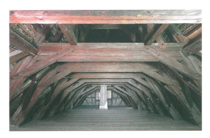
Abb. 6: Thun, Schloss. Mittlerer Abschnitt des südlichen Schlosstrakts, liegender Dachstuhl des Kernbaus von 1566/67. Blick nach Nordwesten.
