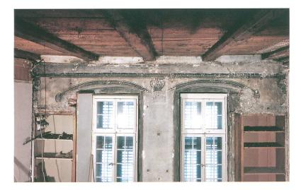
Abb. 7: Thun, Schloss. Mittlerer Abschnitt des südlichen Schlosstrakts, kleiner Saal im ersten Obergeschoss des Kernbaus. Die Decke dürfte etwa zeitlich parallel zum Dachstuhl um 1566/67 entstanden sein. Die spätbarocke Grisaille-Malerei von 1700 an der Südwand deutet die ehemalige Fenstergliederung an. Blick nach Südwesten.
