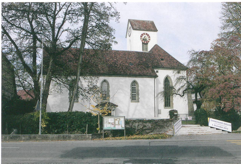
Abb. 1: Koppigen, Hauptstrasse 3. Ansicht der Kirche von Süden.
