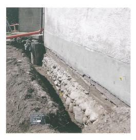
Abb. 3: Koppigen, Hauptstrasse 3. Ostseite des Hauptchors mit dem freigelegten Feldsteinfundament. Blick nach Süden.
