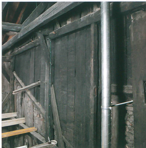
Abb. 16: Thun, Obere Hauptgasse 3. Detail aus dem Dachgerüst des Hauses 7 (kurz nach 1571), Stockwerk des Südostgiebels zwischen den beiden Kehlbalkenlagen. Die Verbreiterung war in eine lange Strebe eingenuet, welche die Dachneigung des zurückgebauten Hauses 5 (um 1530) nachzeichnet. Blick nach Südosten.
