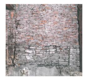
Abb. 17: Thun, Obere Hauptgasse 3. Detail der südöstlichen Giebelwand. Mit der verputzten Wand 71 (unten) wurde kurz nach 1571 ein durchgehender Raum im Hinterhaus 6 (um 1530) abgeteilt. Darüber erhebt sich eine aus wiederverwendeten Tonplatten und Abbruchmaterial bestehende Mauer 72 Blick nach Südosten.
