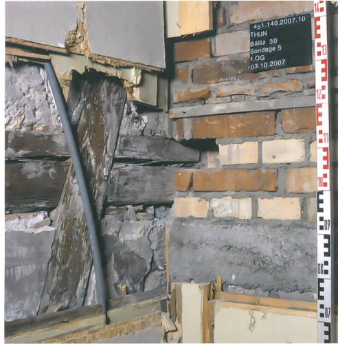
Abb. 27: Thun, Bälliz 30. Baunaht zwischen der nordwestlichen Fachwerkwand (38) des Hauses 5 (1825/33) und der Backsteinfassade, die nach 1885 entstand. Blick in die nordöstliche Hausecke des oberen Stockwerkes.
