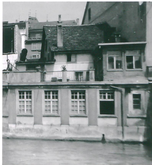
Abb. 7: Thun, Bälliz 30. Der fünfschossige eingeschossige Saal gehörte zur Gastwirtschaft «Zum Kanonier». Er entstand 1926 und reichte bis zum Aareufer. Dahinter ist der hohe Kernbau erkennbar, der zwischen 1885 und 1909 durch die Aufstockung der alten Bausubstanz entstand. Zustand 1972. Blick nach Osten.
