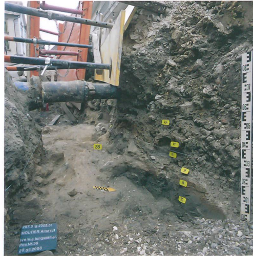
Fig. 18: Moutier, Vieille Ville. Le mur 36, observé dans des conditions difficiles en 2008, constituerait la limite ouest des bâtiments monastiques.
