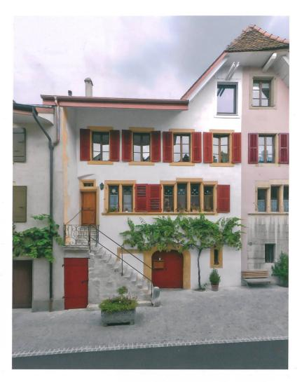
Fig. 4: La Neuveville, Rue du Faubourg 21-25. Facade sud restaurée avec une partie de la facade du bien voisin à l'est, réalisée par symétrie. Vue vers le nord.
