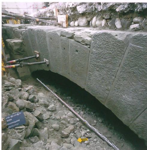
Abb. 5: Bern, Kochergasse. Ansicht des Brückenbogens von Nordwesten.
