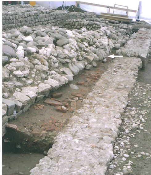
Abb. 7: Attiswil, Leimenstrasse 15. Die Aussenfront des nordöstlichen Eckverbands fehlt (Pfeil). Blick nach Norden.
