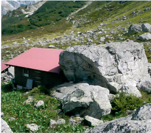
Abb. 19: Innertkirchen, Zum See. Im Schutz eines Felsblocks gebaute Alphütte. Blick nach Osten.
