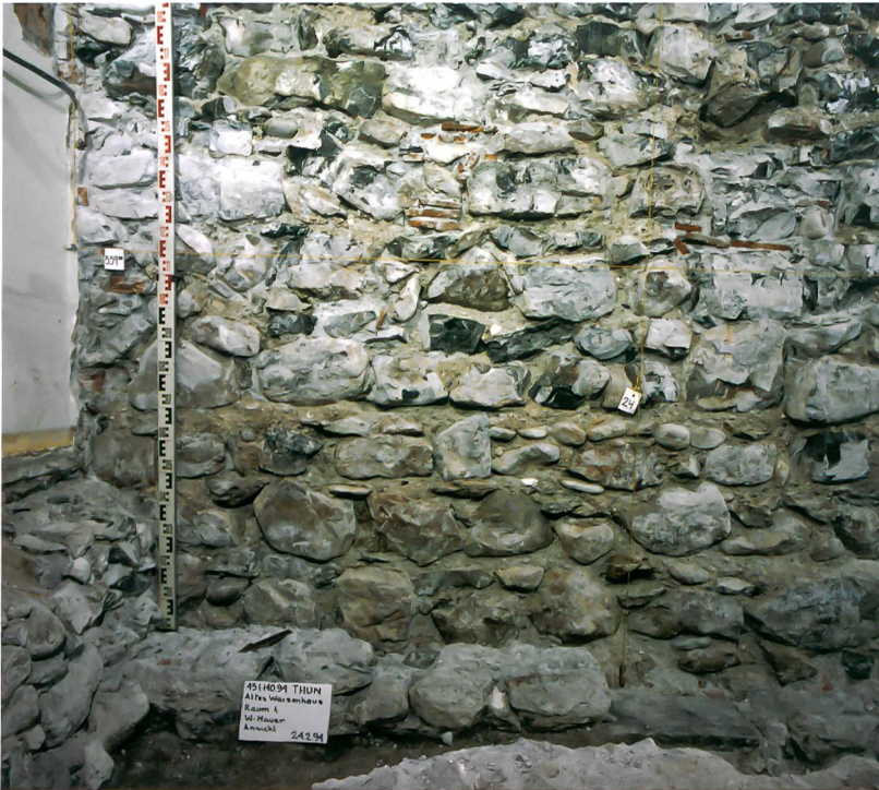
Abb. 4: Thun, Altes Waisenhaus. Ansicht der westlichen Aussenmauer des spätmittelalterlichen Ursprungsbaus im Erdgeschoss, Ansicht gegen Osten.
