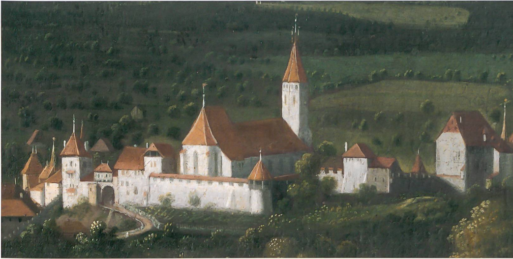
Abb. 2: Thun, Schlossberg, Kirchhofmauer. Ansicht des späten 17. Jahrhunderts. Anonymes Aquarell, Historisches Museum Bern.
