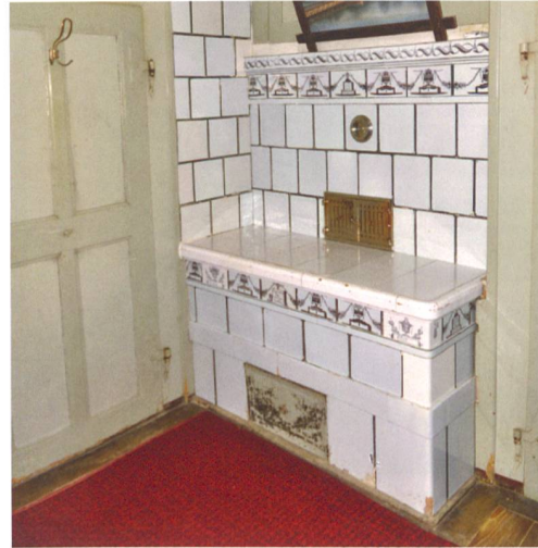
Abb. 71: Schwarzhäusern BE, Ländte 16. Kachelofen des Johann und des Johann David Staub, 1835. Der zweite Ofenteil heizt den Nebenraum.
