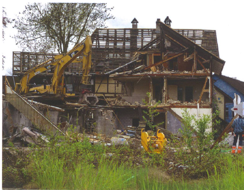
Abb. 3: Langenthal, St. Urbanstrasse 40–44. Abbruch der Liegenschaft im Jahr 2010.
