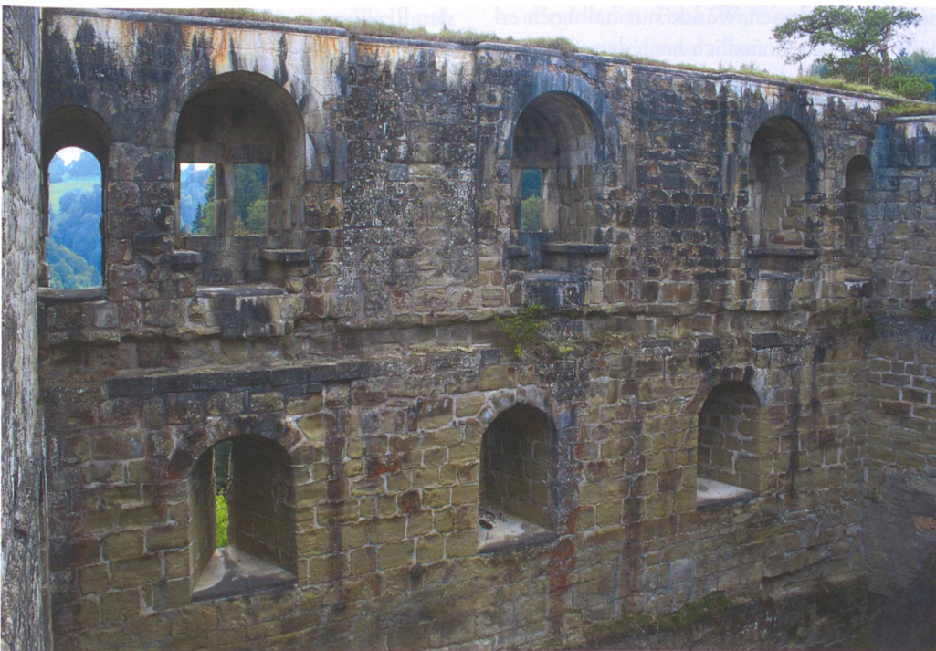
Abb. 9: Die Grasburg bei Wahlern. Die Südwand des Saales, Innenseite, 2009.
