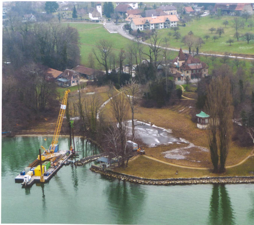
Abb. 2 und 3: Sutz-Lattrigen. Bau der neuen Tauchbasis Bielersee. Sämtliche Transporte kamen über den Wasserweg und die Arbeiten wurden von einem Schwimmponton aus ausgeführt.
