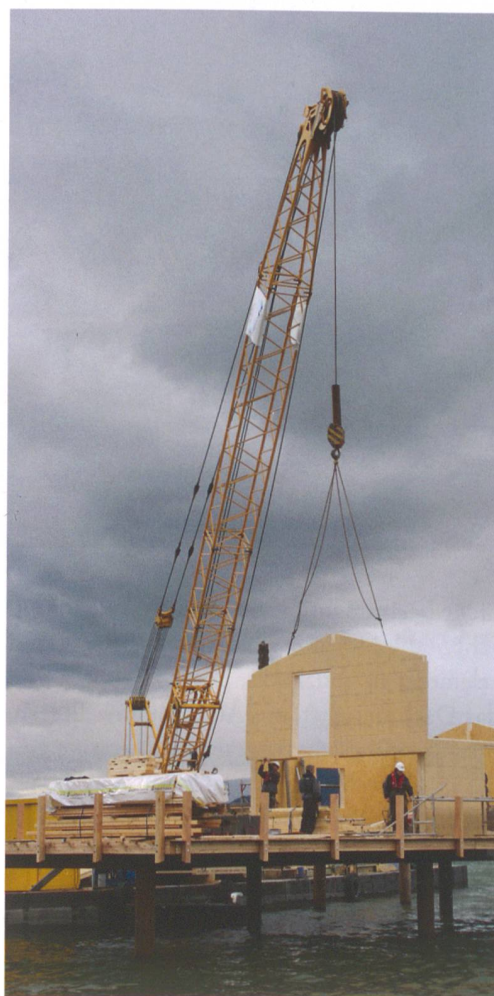
Abb. 2 und 3: Sutz-Lattrigen. Bau der neuen Tauchbasis Bielersee. Sämtliche Transporte kamen über den Wasserweg und die Arbeiten wurden von einem Schwimmponton aus ausgeführt.
