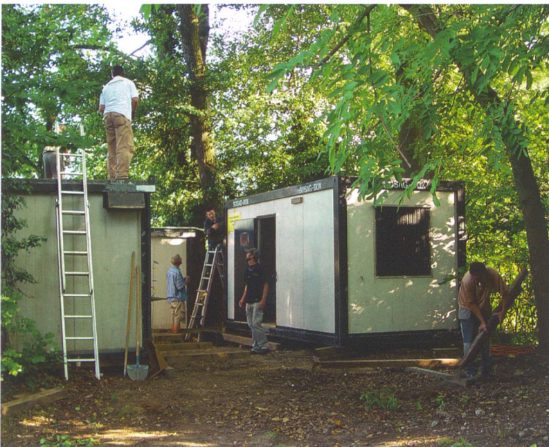
Abb. 1: Sutz-Lattrigen. Abbau der alten Tauchbasis nach über 20 Jahren Nutzung. Die drei Baucontainer waren von Oktober 1988 bis August 2009 auf dem Gelände der Ziegelhütte in Lattrigen aufgestellt.
