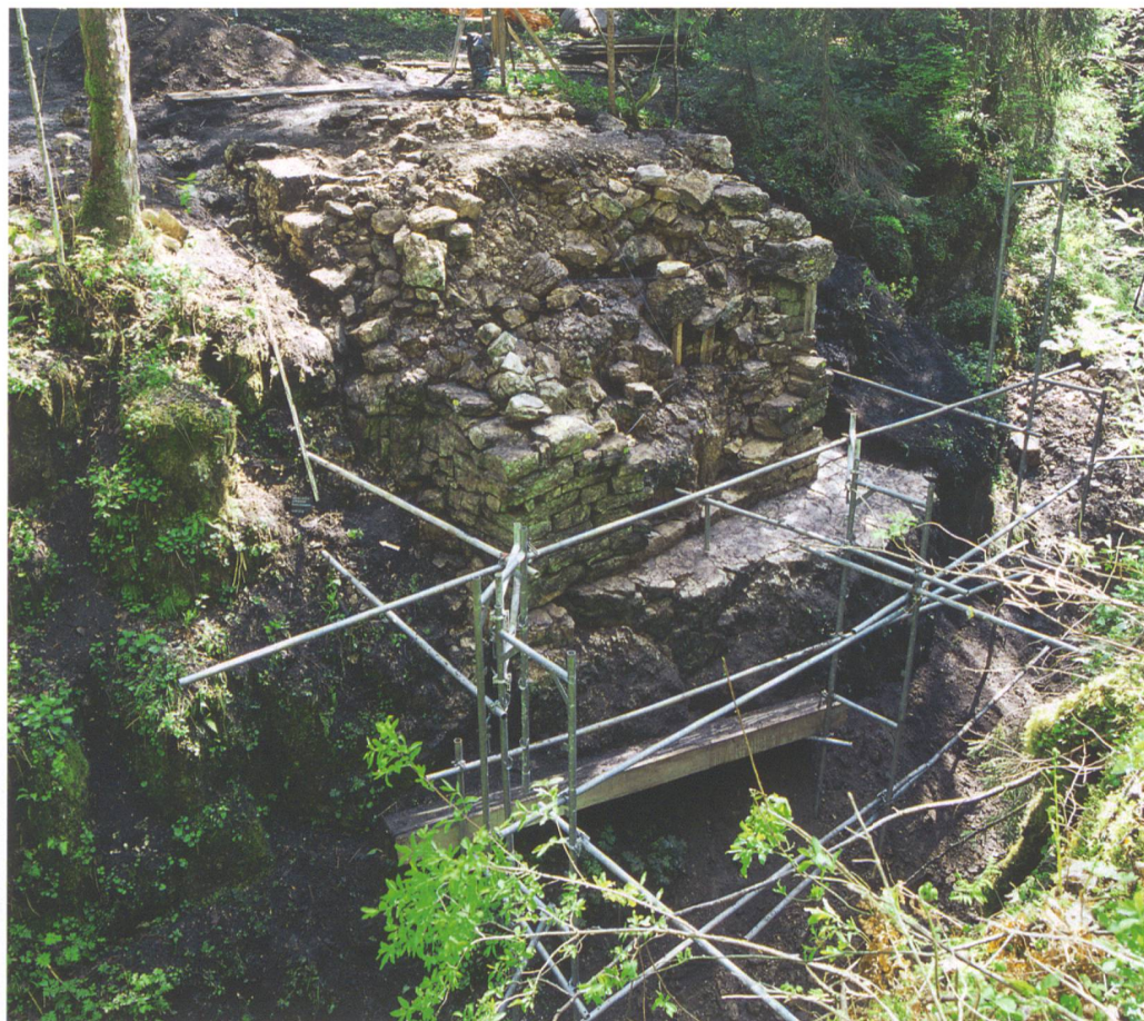
Fig. 3 : Corgémont, Pont des Anabaptistes. Culée ouest dégagée.
