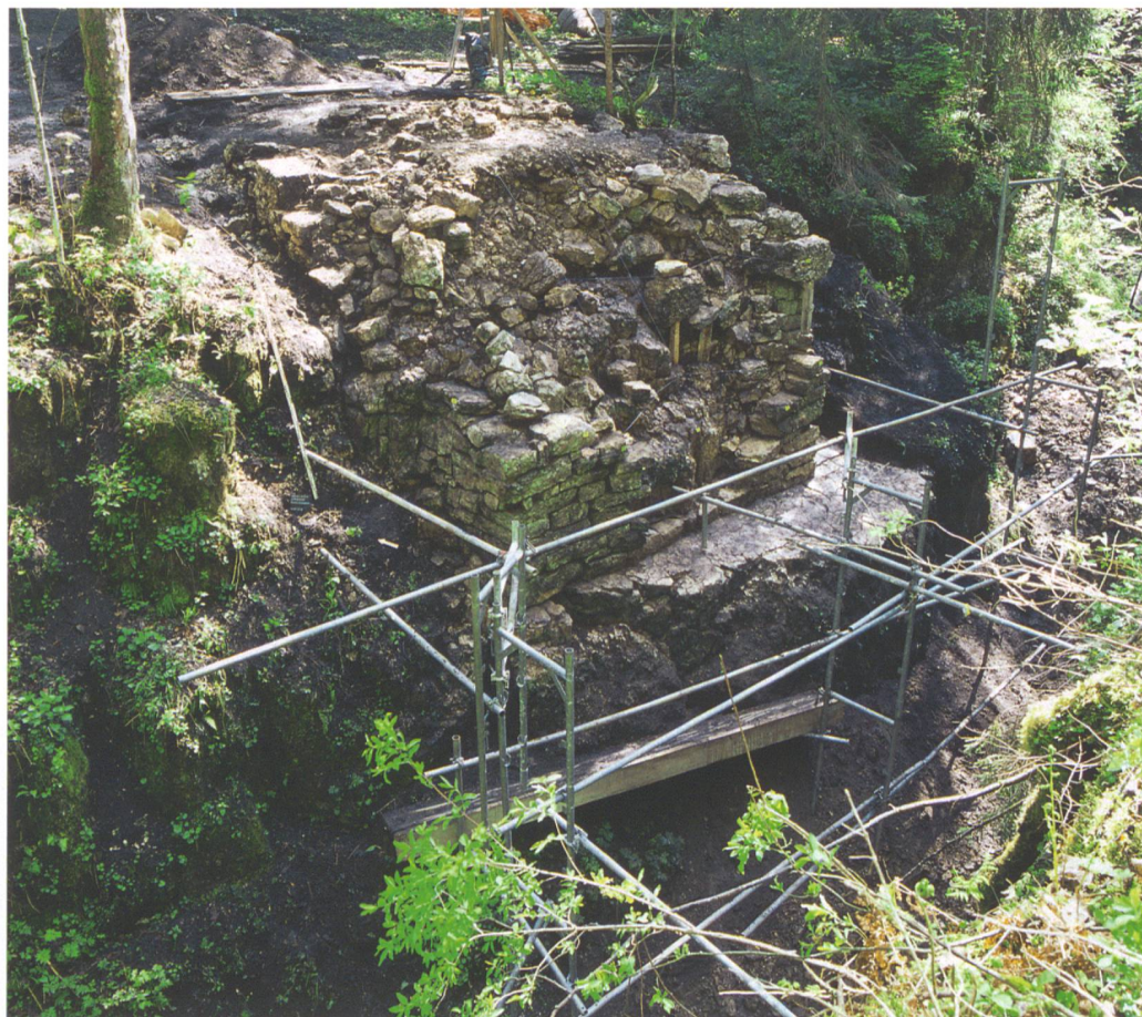
Fig. 3 : Corgémont, Pont des Anabaptistes. Culée ouest dégagée.
