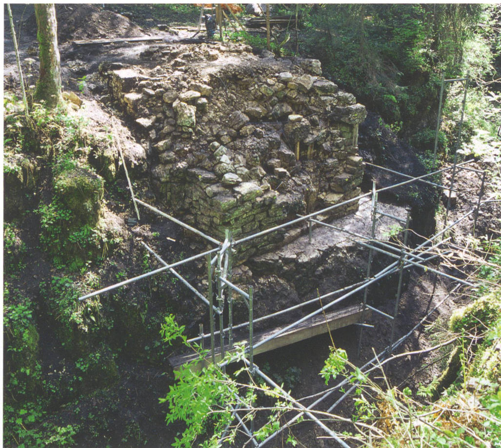
Fig. 3 : Corgémont, Pont des Anabaptistes. Culée ouest dégagée.
