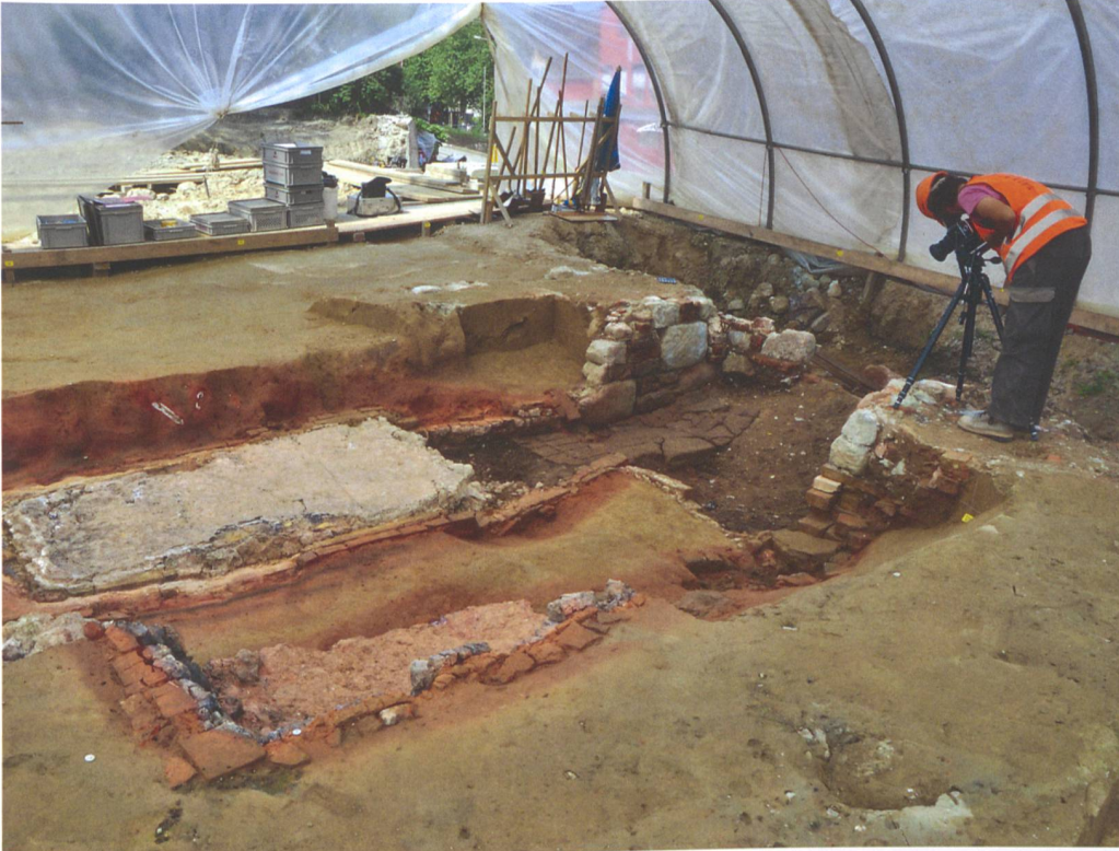
Abb. 4: Langenthal, St. Urbanstrasse 40–44. Reste zweier Töpferöfen der Hafnerei Staub, die auf diesem Grundstück von 1730 bis 1870 Geschirrkemik und Kachelöfen produzierte.
