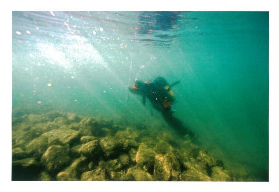
Abb. 3. Vinelz, Underi Budlei. Ansicht des Steindamms aus grossen Blöcken. Die Anlage wurde Ende des 19. Jahrhunderts errichtet.
