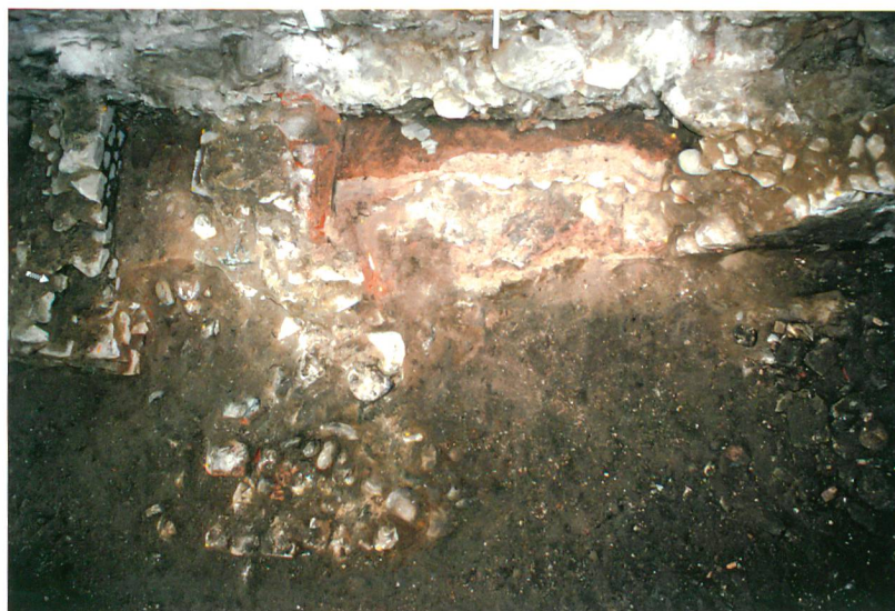
Abb. 8: Niederbipp, Kirchgasse 13, Pfarrscheune, Ausgrabungen 1972. Die Mauer 11 (links) stört die Terrazzoböden 10 der Badeanlage (Mitte) und ist ihrerseits an dieser Stelle abgebrochen. Blick nach Westen.
