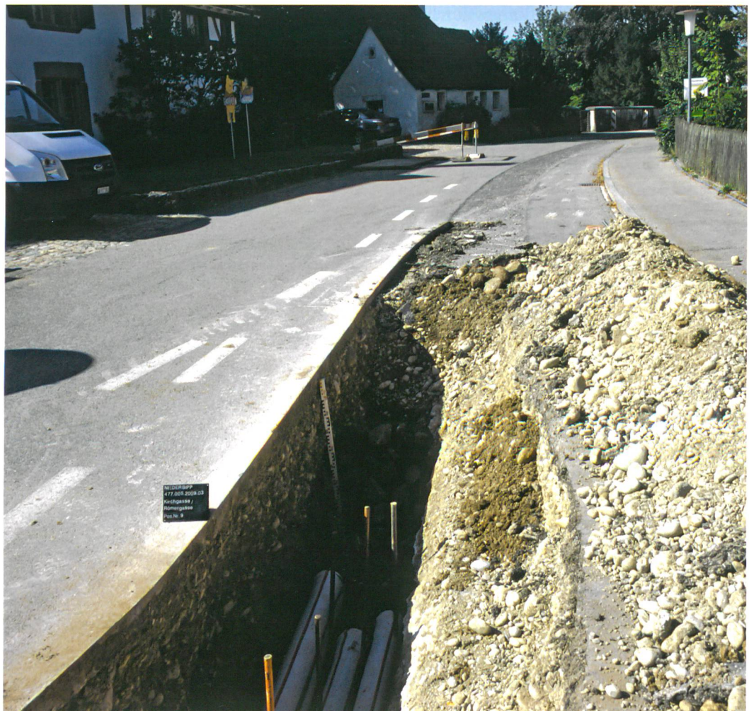
Abb. 1: Niederbipp, Kirchgasse. Werkleitungsanierung 2009. Im Vordergrund angeschnittene Grabgrube 23. Blick nach Westen.
