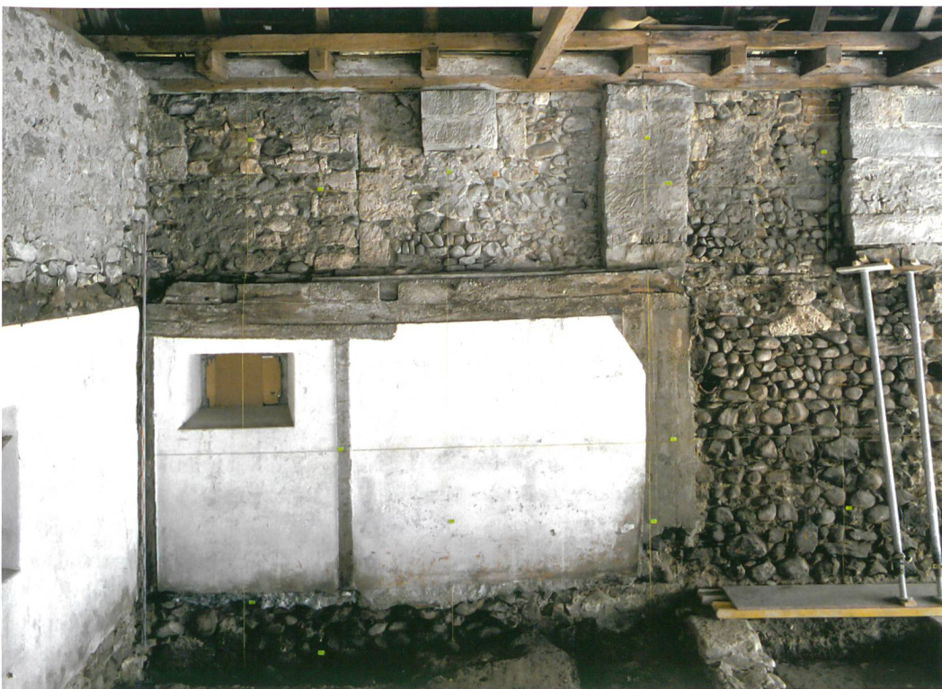
Abb. 6: Köniz, Schloss, Muhlenstrasse 15. Ansicht der Nordmauer. Die Zinnen aus Tuffsteinquadern wurden durch die modernen Sandsteinpfeiler gestört.
