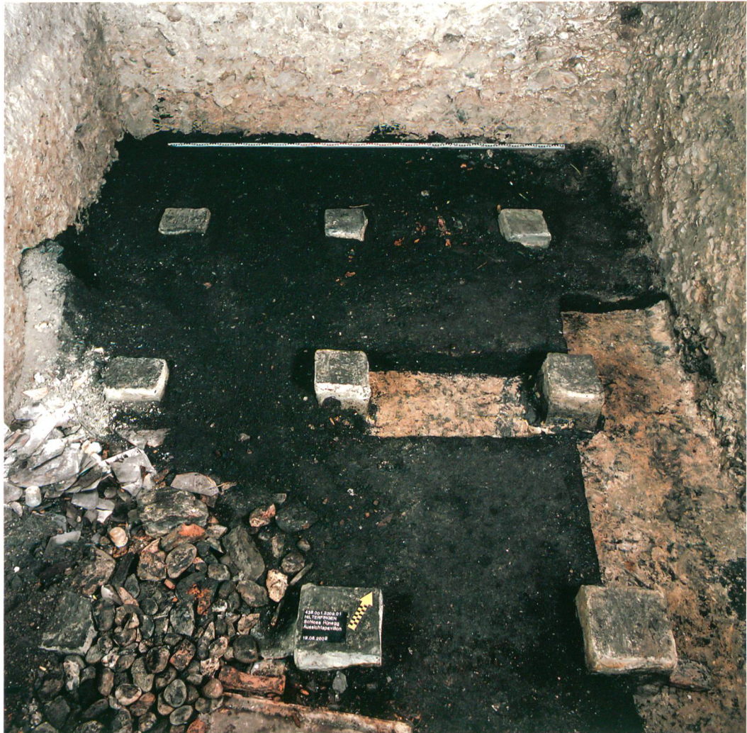
Abb. 5: Hilterfingen, Schloss Hünegg. Am Boden des Eiskellers ist die Schlackenschicht zu sehen, rechts und in der Bildmitte in Streifen freigelegt der Mörtelboden.
