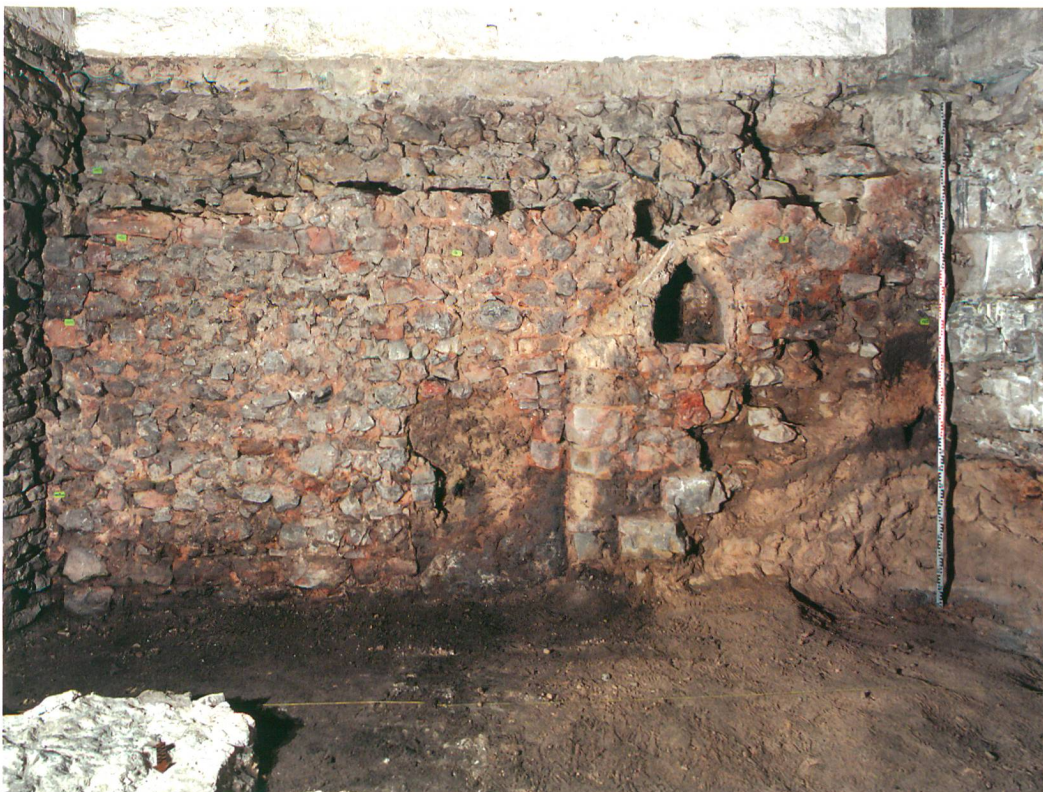
Abb. 4: Biel, Obergasse 4, Kellersüdwand. Ansicht der Mauern (3) / (9) während der Dokumentationsarbeit. Die Mauer (3) wurde der älteren Mauer (9) vorgeblendet. Der Verlauf der abgebrochenen Treppe von der Gasse her ist deutlich erkennbar. Die giebelförmige Lichtnische diente zur Aufnahme eines Talglämpchens zur Beleuchtung. Der oberhalb der Treppe parallel verlaufende Vorsprung könnte ein Hinweis auf eine Holztreppe sein, welche in den Raum über dem Keller führte.
