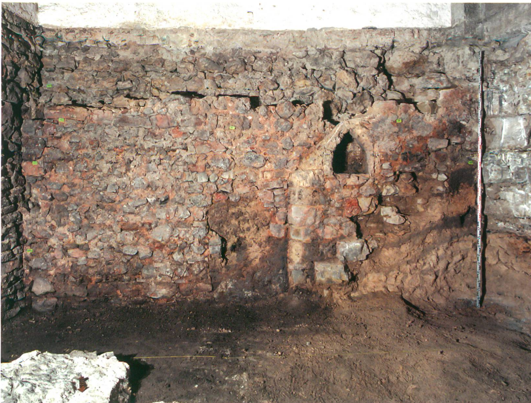
Abb. 4: Biel, Obergasse 4, Kellersüdwand. Ansicht der Mauern (3) / (9) während der Dokumentationsarbeit. Die Mauer (3) wurde der älteren Mauer (9) vorgeblendet. Der Verlauf der abgebrochenen Treppe von der Gasse her ist deutlich erkennbar. Die giebelförmige Lichtnische diente zur Aufnahme eines Talglämpchens zur Beleuchtung. Der oberhalb der Treppe parallel verlaufende Vorsprung könnte ein Hinweis auf eine Holztreppe sein, welche in den Raum über dem Keller führte.
