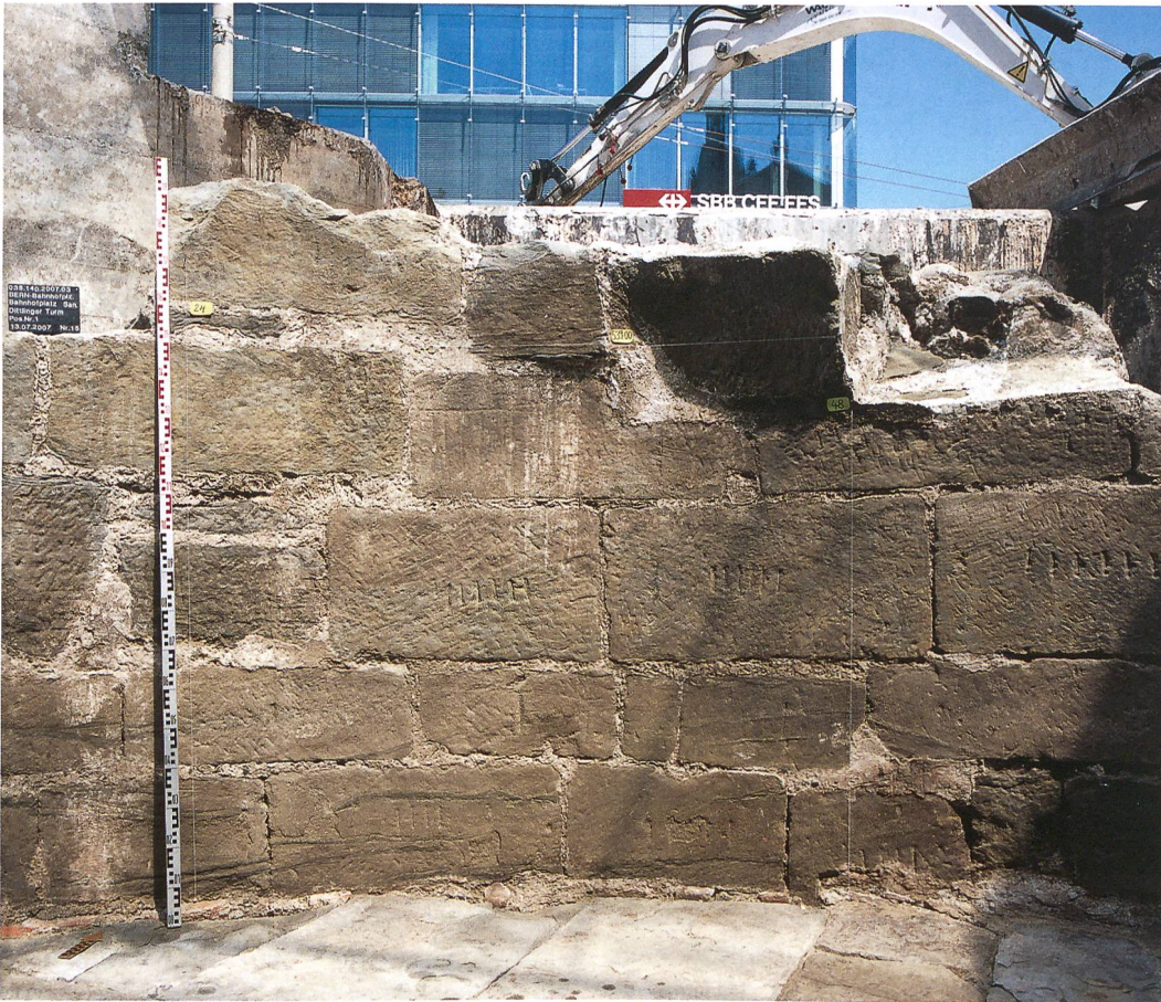
Abb. 25: Bern, Bahnhofplatz. Steinbehau und Schicht-höhenzeichen im Dittlinger-Turm.
