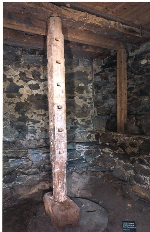
Abb. 3: Innertkirchen, Wyler-Sunnsyten 14. Inneres des Kellers. In der Mitte der drehbare Pfosten.
