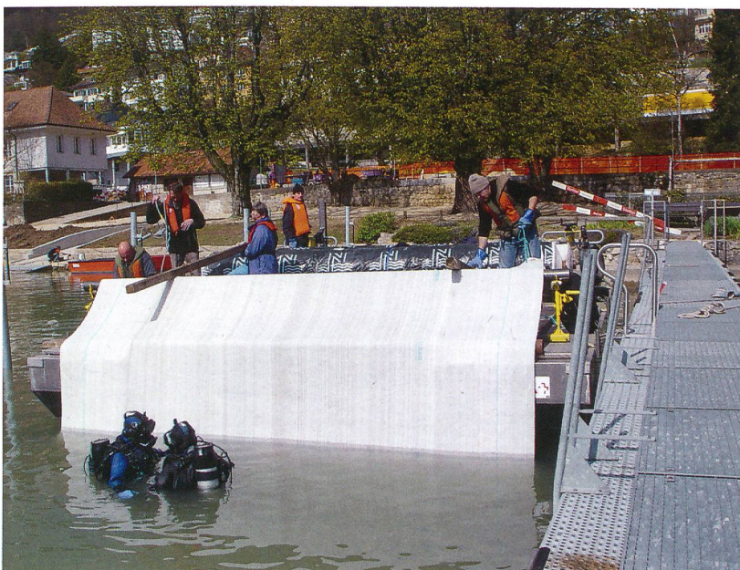
Abb. 6: Biel-Vingelz, Hafen. Schutz der jungsteinzeitlichen Siedlungsschichten im Hafenbereich durch die Verlegung von Geotextil.
