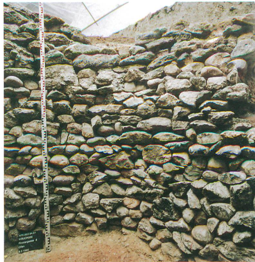
Abb. 6: Herzogenbuchsee, Finstergasse 8. Die in Trockenmauertechnik gefügte Wand (27) des Kalkbrennofens. Blick nach Nordwesten.
