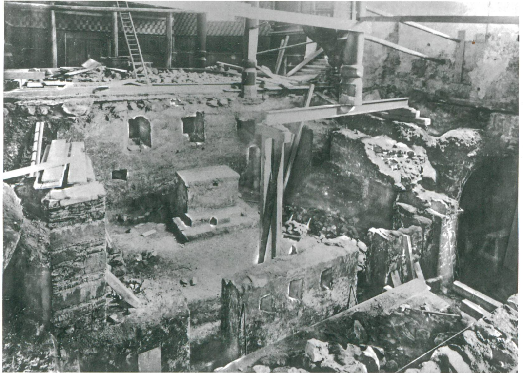
Abb. 2: Die Freilegungen in der Kirche. Aufnahme während der Arbeiten 1915.
