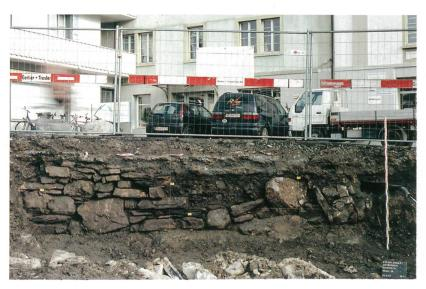
Abb. 8: Unterseen, Spielmatte, Fläche A. Fundament (66) einer Vorgängerbrücke?
