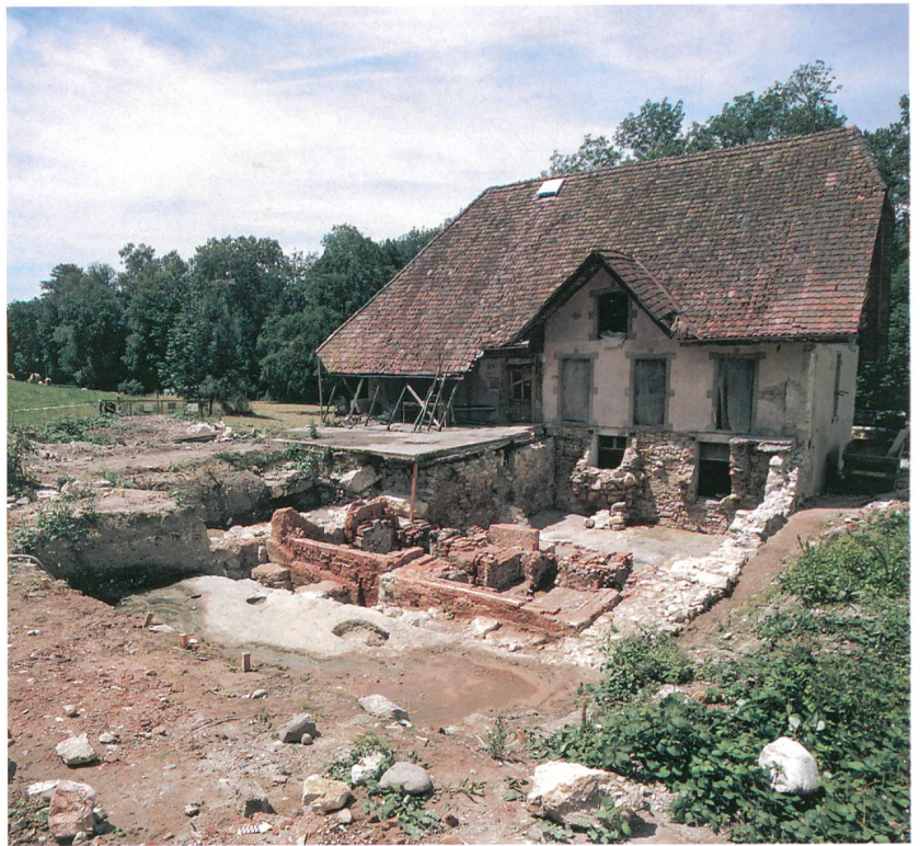
Abb. 3: Sutz-Lattrigen, Ziegelhütte. Das Gebäude (Zustand nach den Umbauten von 1890/91 und 1907) im Jahr 2007. Aufnahme von Süden, im Vordergrund die Fundamente der freigelegten Ziegelöfen.
