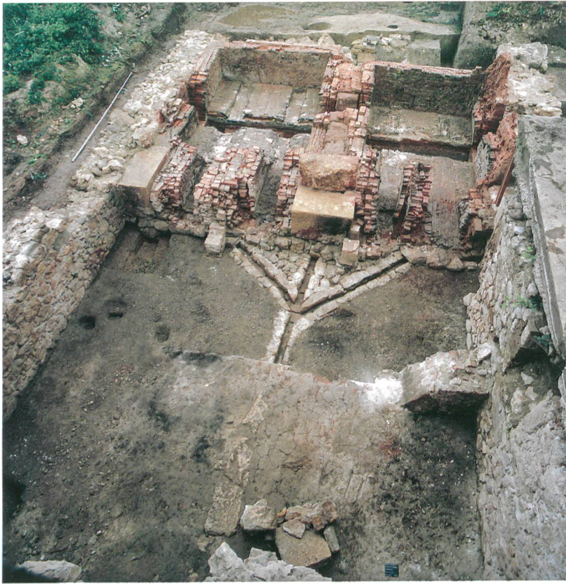
Abb. 4: Sutz-Lattrigen, Ziegelhütte. Blick von Norden auf die Fundamente der beiden Ziegelöfen. Im Vordergrund sind die Kanäle der Ofendrainage freigelegt. Die Entwässerung und Trockenlegung des Ofenuntergrundes war wegen stark drückendem Hangwasser notwendig.
