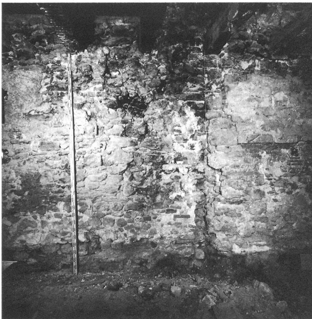
Abb. 8: Biel, Obergässli 5. Der südliche Eckverband von Ostmauer (51) im Erdgeschoss, Blick nach Osten.
