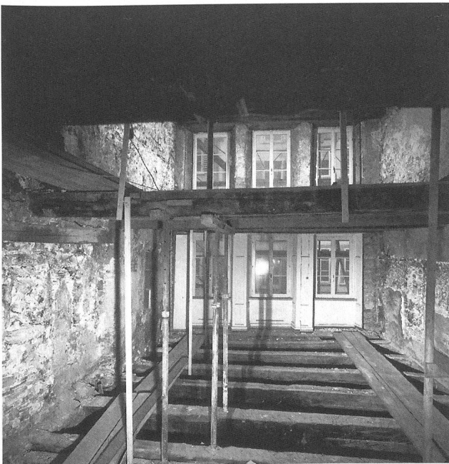
Abb. 16: Biel, Obergässli 5. Das 1. Obergeschoss, Blick nach Süden.
