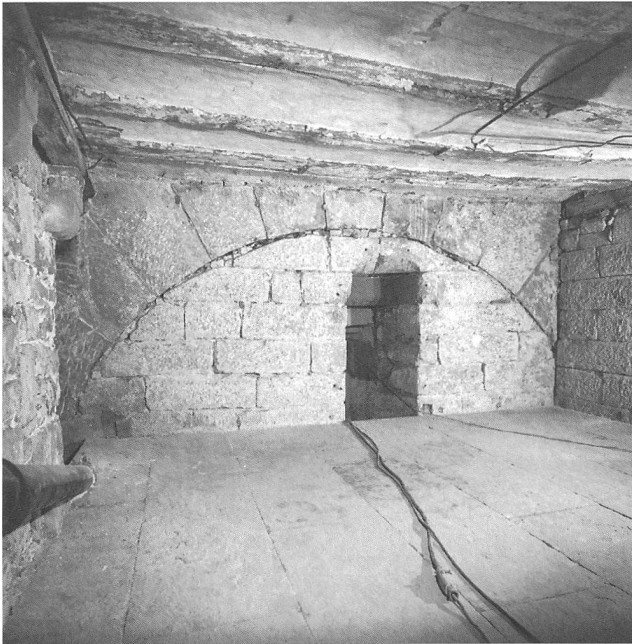
Abb. 15: Die Nordmauer des Lenbrunnens im Erdgeschoss mit dem gewaltigen Stichbogen (345) aus der Zeit um 1851.
