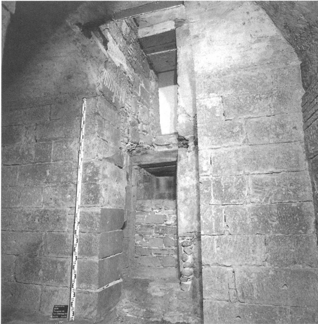
Abb. 14: Schnitt durch die Nordmauer des Lenbrunnens. Oben ist die Türe (366), die an der Stelle des Fensters (373) errichtet wurde, zu erkennen, unten die zum Fenster (372) zugemauerte Türe (362).
