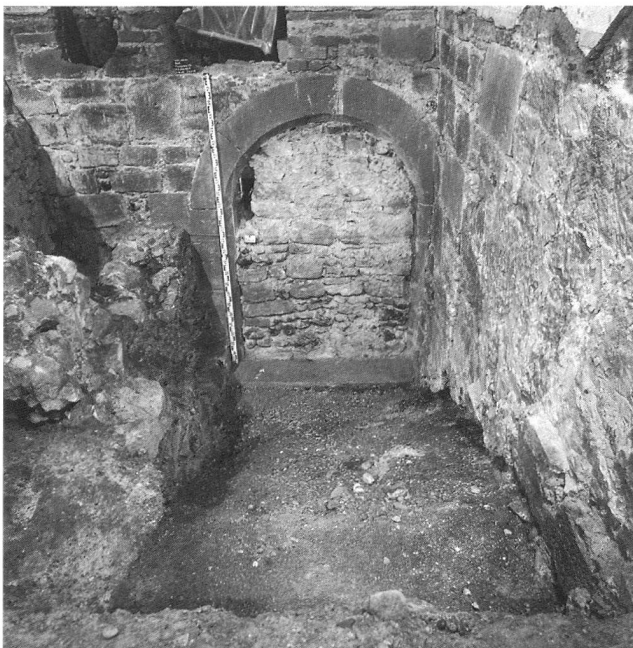
Abb. 28: Der Kellereingang (47) von Raum 2 in Postgasse 70 gegen Norden.
