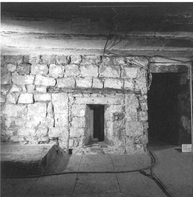
Abb. 8: Innenansicht der entmörtelten Südmauer im Erdgeschoss mit dem Sturz und der Laibung von Türe (321).
