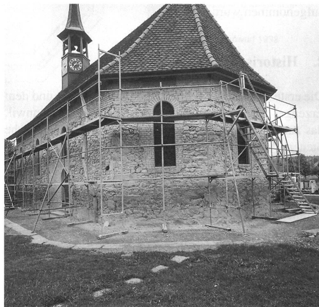
Abb. 2: Die Kirche Bannwil während der Fassadenrenovation von 1993, von Südosten.
