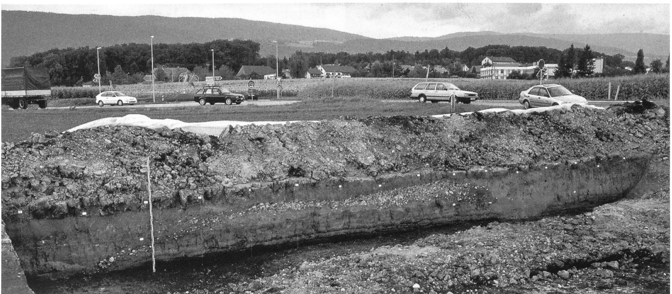
Abb. 251: Gals - Usseri Allmele 2002. Im Profil erkennen wir die beiden alten, kiesigen Strassenkörper. Im Hintergrund verläuft die heutige Kantonsstrasse Gampelen-Zihlbrücke. Blick nach Norden.
