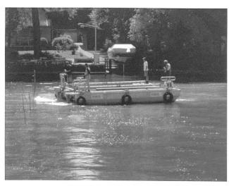
Abb. 48: Sutz-Lattrigen, Erosionsschutzmassnahmen 2003. Der Kieskatamaran wird an die markierte Verklappungsstelle manövriert.
