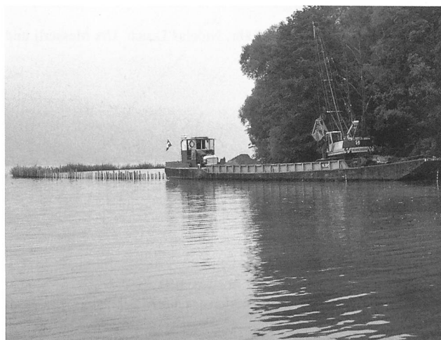
Abb. 61: Sutz-Lattrigen - Rütte 1998. Kiesschüttung zur Sohlensicherung der Lahnung im bereits ausgegrabenen Bereich. Blick nach Nordosten.
