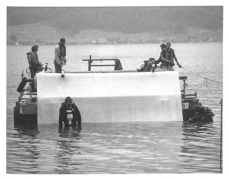
Abb. 45: Sutz-Lattrigen - Hauptstation, Erosionsschutzmassnahmen 2003. Verlegen des Geotextils.
