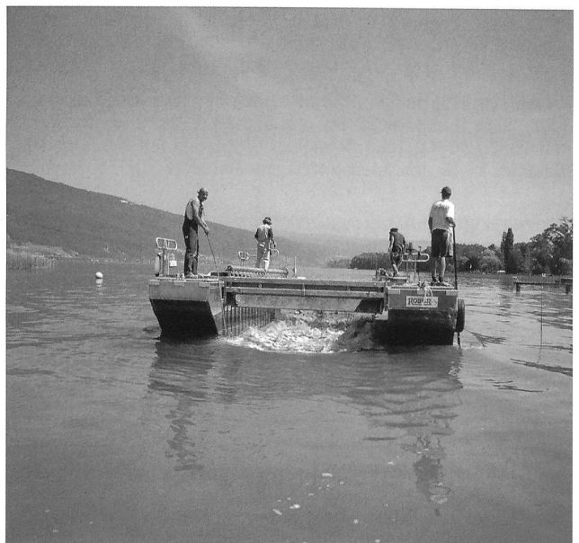
Abb. 49: Sutz-Lattrigen, Erosionsschutzmassnahmen 2003. Verklappen des Kieses an der vorgesehenen Stelle.
