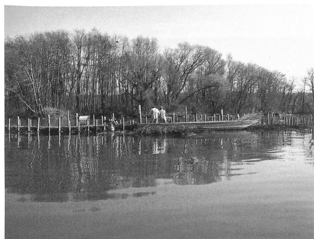
Abb. 60: Sutz-Lattrigen - Rütte 1998. Mitarbeiter des Arbeitswerks des Vereins Bielerseeschutz legen im Frühling Weidenfaschinen zwischen die doppelte Pfahlreihe der Lahnung ein. Blick nach Südosten.
