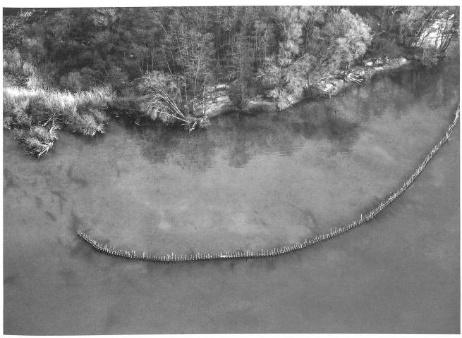
Abb. 59: Sutz-Lattrigen - Rütte 1998. Bau des Wellenbrechers. Die Doppelpfahlreihe für die Lahnung wurde in den Wintermonaten erstellt. Blick nach Osten.
