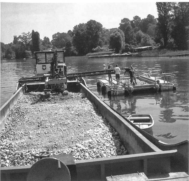
Abb. 46: Sutz-Lattrigen, Erosionsschutzmassnahmen 2003. Umladen des Kieses mit Hilfe von Bagger und Förderband.
