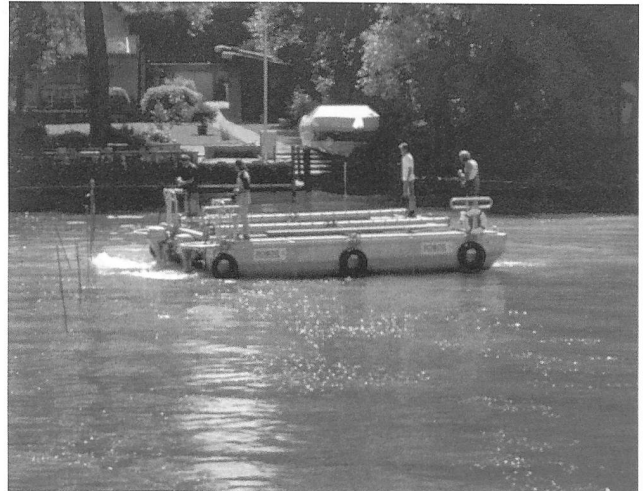
Abb. 48: Sutz-Lattrigen, Erosionsschutzmassnahmen 2003. Der Kieskatamaran wird an die markierte Verklappungsstelle manövriert.
