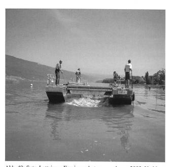
Abb. 49: Sutz-Lattrigen, Erosionsschutzmassnahmen 2003. Verklappen des Kieses an der vorgesehenen Stelle.
