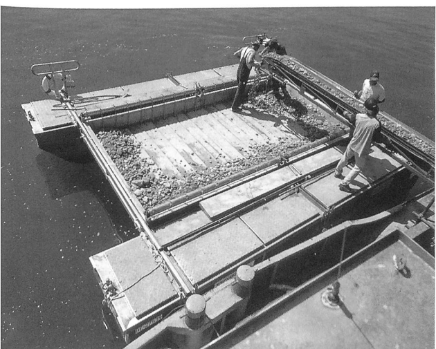
Abb. 47: Sutz-Lattrigen, Erosionsschutzmassnahmen 2003. Der Kieskatamaran mit Jalousieboden wird mit Kies gefüllt.
