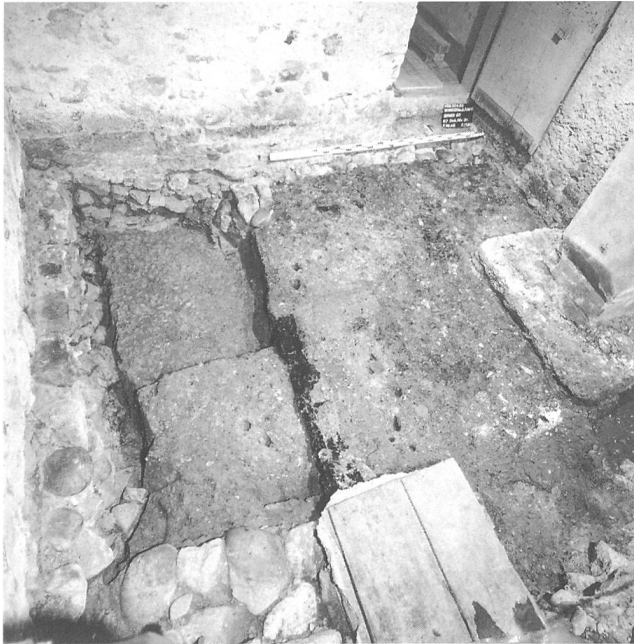
Abb. 18: Wangen, Städtli 60. Holzfundament (71) mit Blick gegen Norden.
