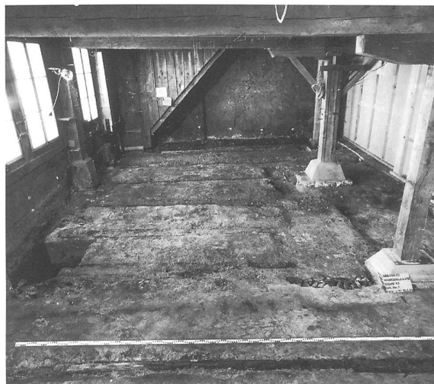
Abb. 11: Wangen, Städtli 42. Die Balkenlager (5) und (22) zum Boden der jüngsten Phase. Blick gegen Norden.
