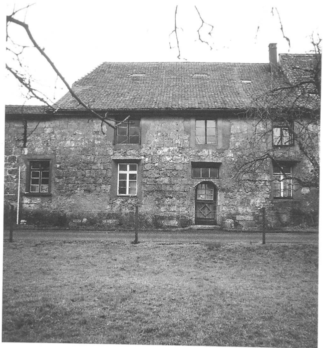
Abb. 5: Die Westfassade von Städtli 42 besteht grösstenteils noch aus der mittelalterlichen Stadtmauer. Blick gegen Osten.
