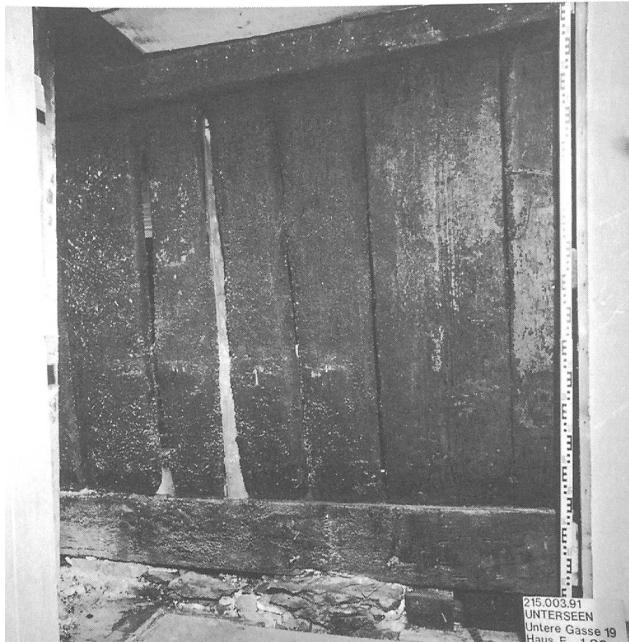
Abb. 12: Unterseen, Under de Hüsere 18. Zweiter Umbau des Kernbaus, zweites Wohngeschoss, Trennwand mit Schwelle (35), Bohlenwand (49) und Bundbalken (47). Blick nach Süden (vgl. Abb. 10).
