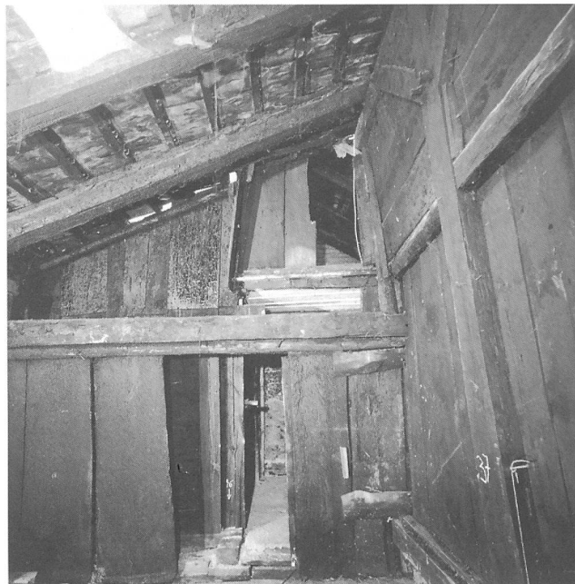
Abb. 13: Unterseen, Under de Hüsere 18. Zweiter Umbau des Kernbaus, Dachgeschoss, Bundbalken (59), Kehlbalken (60) und Bohlenwand (55). Blick nach Süden (vgl. Abb. 10).
