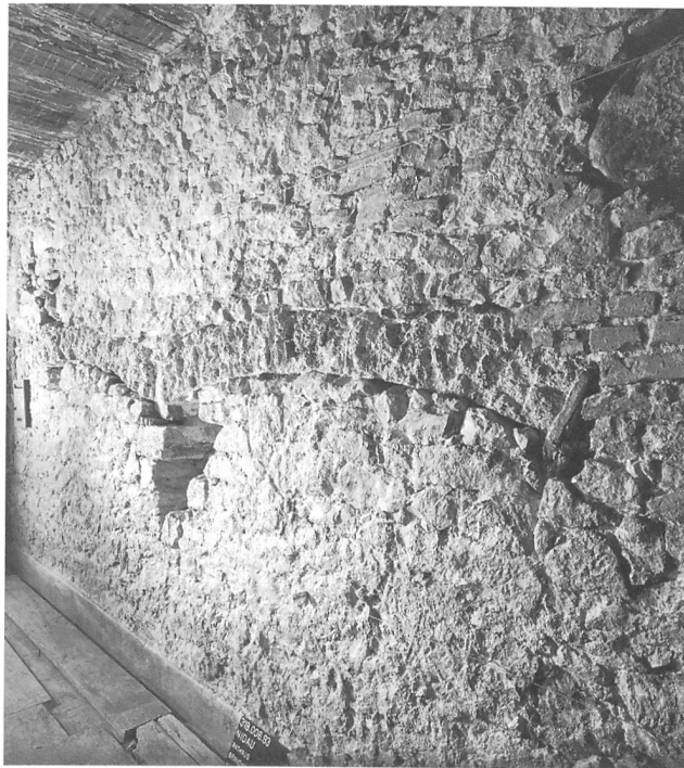
Abb. 9: Nidau, Rathaus. Östlicher Teil der Südmauer (107) mit den beiden Stichbögen (112).
