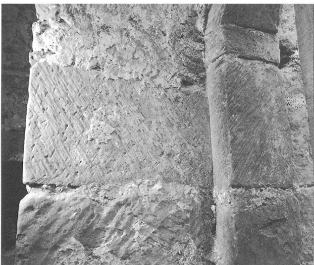
Abb. 21: Geflächte Gewändequader der Rundbogentüre.
