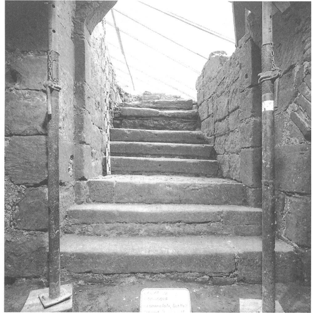
Abb. 22: Kellerhals IV mit Ansätzen der Rundbogentüre der zweiten Kellerphase gegen Osten.
