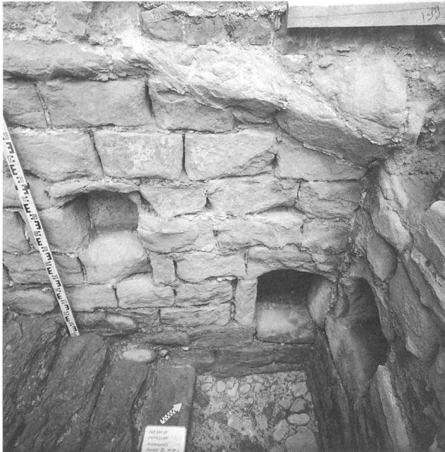
Abb. 17: Die beiden Lichtnischen (143 und 144) im ehemals tonnenüberwölbten Kellerabgang VII der ersten Kellerphase, Blick nach Norden.
