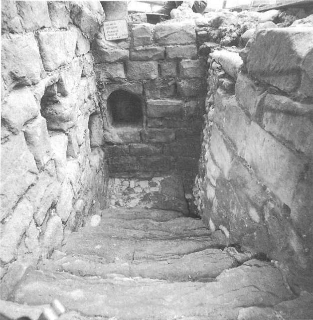
Abb. 15: Kellerhals VII der ersten Kellerphase gegen Osten.
