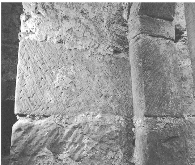
Abb. 21: Geflächte Gewändequader der Rundbogentüre.
