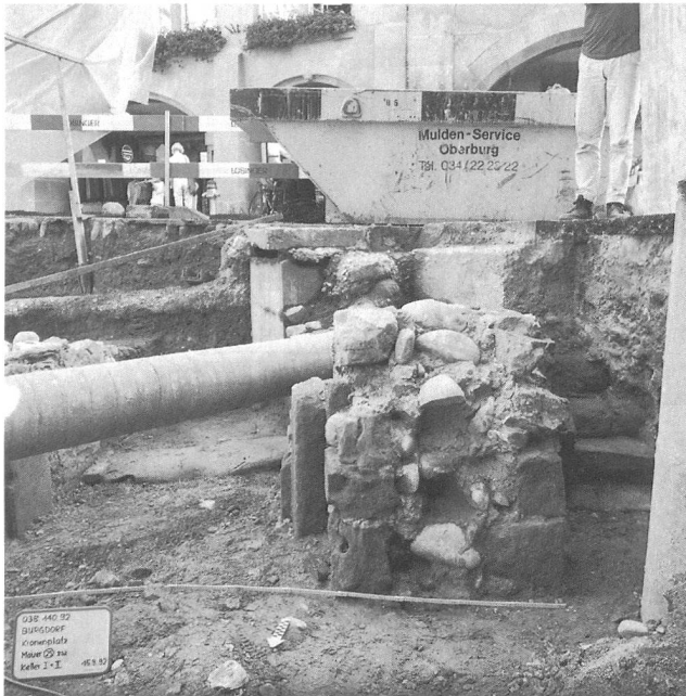
Abb. 13: Die geschnittene Mauer (M-25) zwischen Keller I und II gegenüber Süden. Rechts die vier Stufen des Kellereinganges im Süden des Kellers I.
