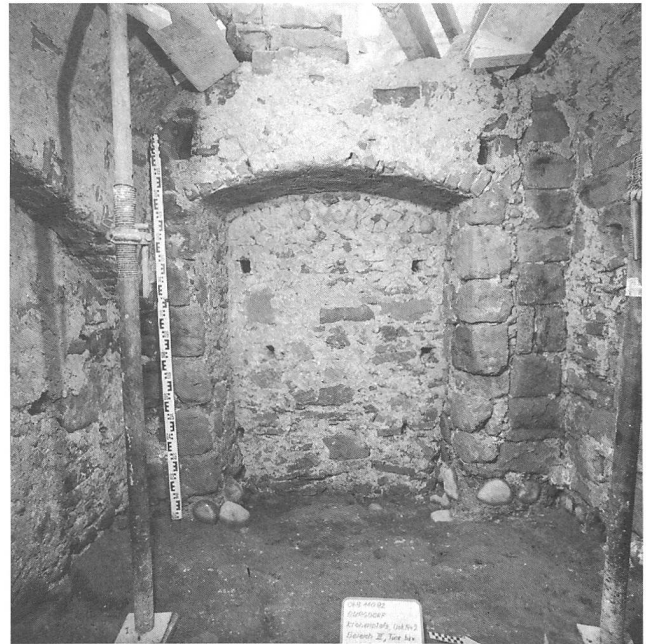
Abb. 24: Einwölbung des in der dritten Kellerphase zur Nische gewordenen ehemaligen Vorraumes III.
